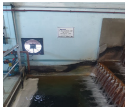
Mise en service filtre à charbons actifs
